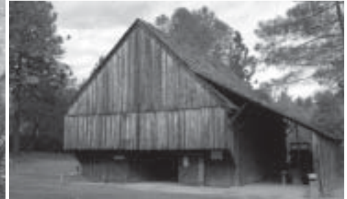
Shasta SHP barn
